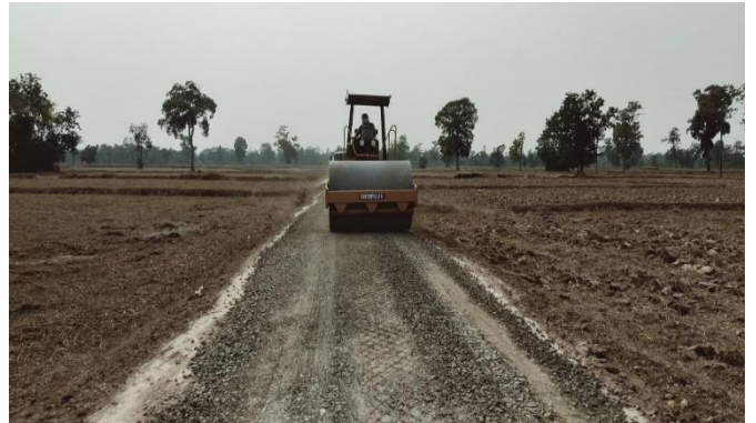
๑๓.โครงการก่อสร้างถนนลงหินคลุก สายนานาชาติ บุกุมมี – ถนนภูมิสีตัง โคกป่นโร หมู่ที่ ๗ บ้านภูมิสีตัง ตำบลโชคเหนือ อำเภอลำดวน จังหวัดสุรินทร์
